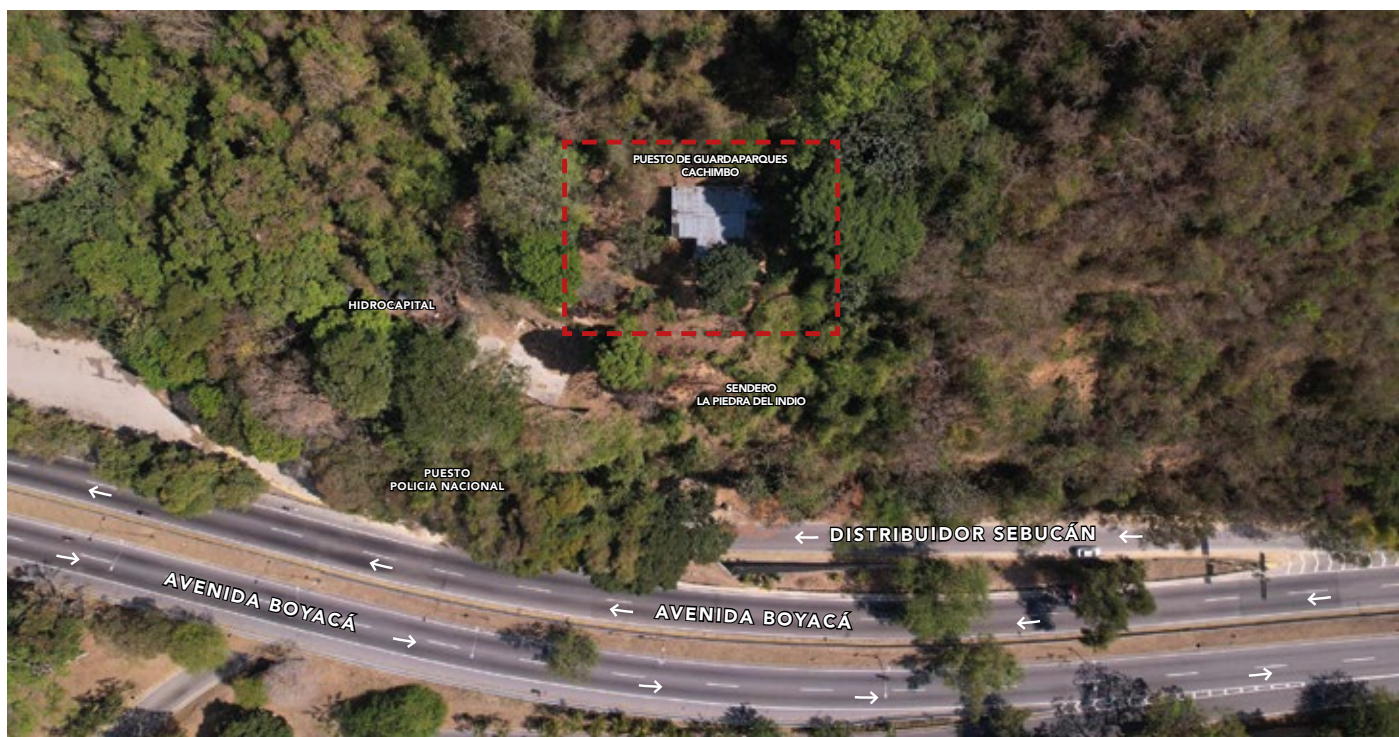
Puesto de Guarda Parques Cachimbo, ubicado en Parque Nacional Waraira Repano, en las cercanías del Parque Los Chorros
